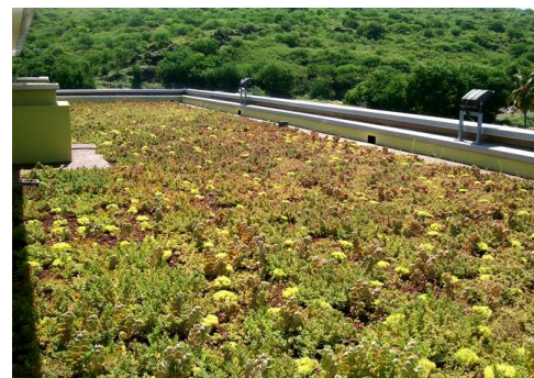
Station d'épuration - Ermitage
